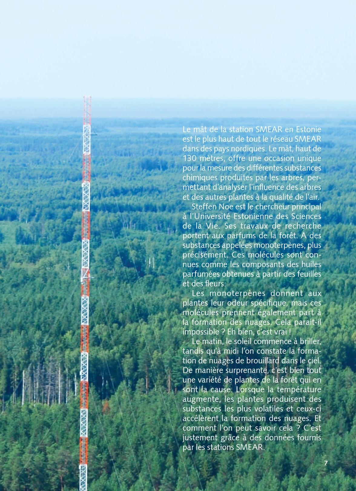
Le mât de la station SMEAR en Estonie est le plus haut de tout le réseau SMEAR dans des pays nordiques. Le mât, haut de 130 mètres, offre une occasion unique pour la mesure des différentes substances chimiques produites par les arbres, permettant d'analyser l'influence des arbres et des autres plantes à la qualité de l'air.
